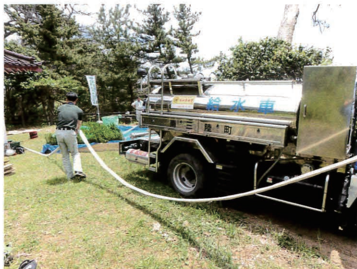
南三陸町給水車による注水作業
